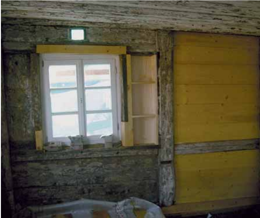
▲ Bei einem Wandteil der Bohlenstube war in früherer Zeit das Holz durch Mauerwerk ersetzt worden, es wurde in seinen ursprünglichen Zustand zurückversetzt (s. a. S. 14, Abb. 11)
