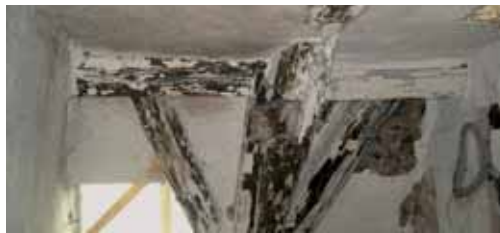
▲ Alte Konstruktionen wurden sorgsam ergänzt, um so viel Substanz wie möglich zu erhalten, hier und links oben im Bereich des Dachstuhls.
