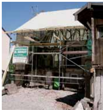
▲ Hofansichten während der Instandsetzung: Ein Notdach schützt die verbliebene Fachwerkkonstruktion des Haupthauses, solange das Dach offen ist.
