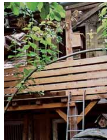
Der Zustand im Juni 2004: Der Bau ist abgestützt, Wände mussten zum Teil mit Armierungseisen gesichert werden, der Hof ist zugewuchert, mit allerlei Material vollgestellt, Dächer sind stark beschädigt, Teile der Zinkburg abgetragen.
