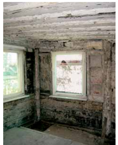
▲ Zustand vor Beginn der Arbeiten im Jahr 2005. Hier ist ein Stück des historischen Gipsestriches nach Aufnahme der Bodendielen sichtbar.
