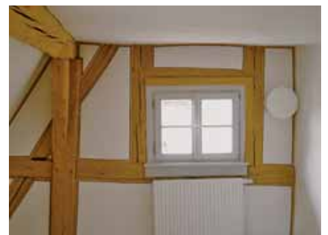
▲ Ostwand im Haupthaus während der Lehmrestaurierung, unten nach der Instandsetzung.
