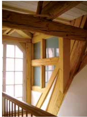
▲ Diele im Dachgeschoss mit Blick in die alte Aufzugsgaube.
