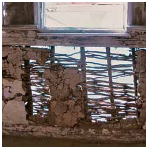
So sah die „Zinkburg“ im Frühjahr 2006 aus: nach dem „Entmüllen“ des Innenbereiches und des Hofes, entrümpelt und entkernt. Der Putz an den Fassaden ist entfernt, Fachwerkkonstruktionen freigelegt, Schäden u. a. an tragenden Elementen werden sichtbar.
