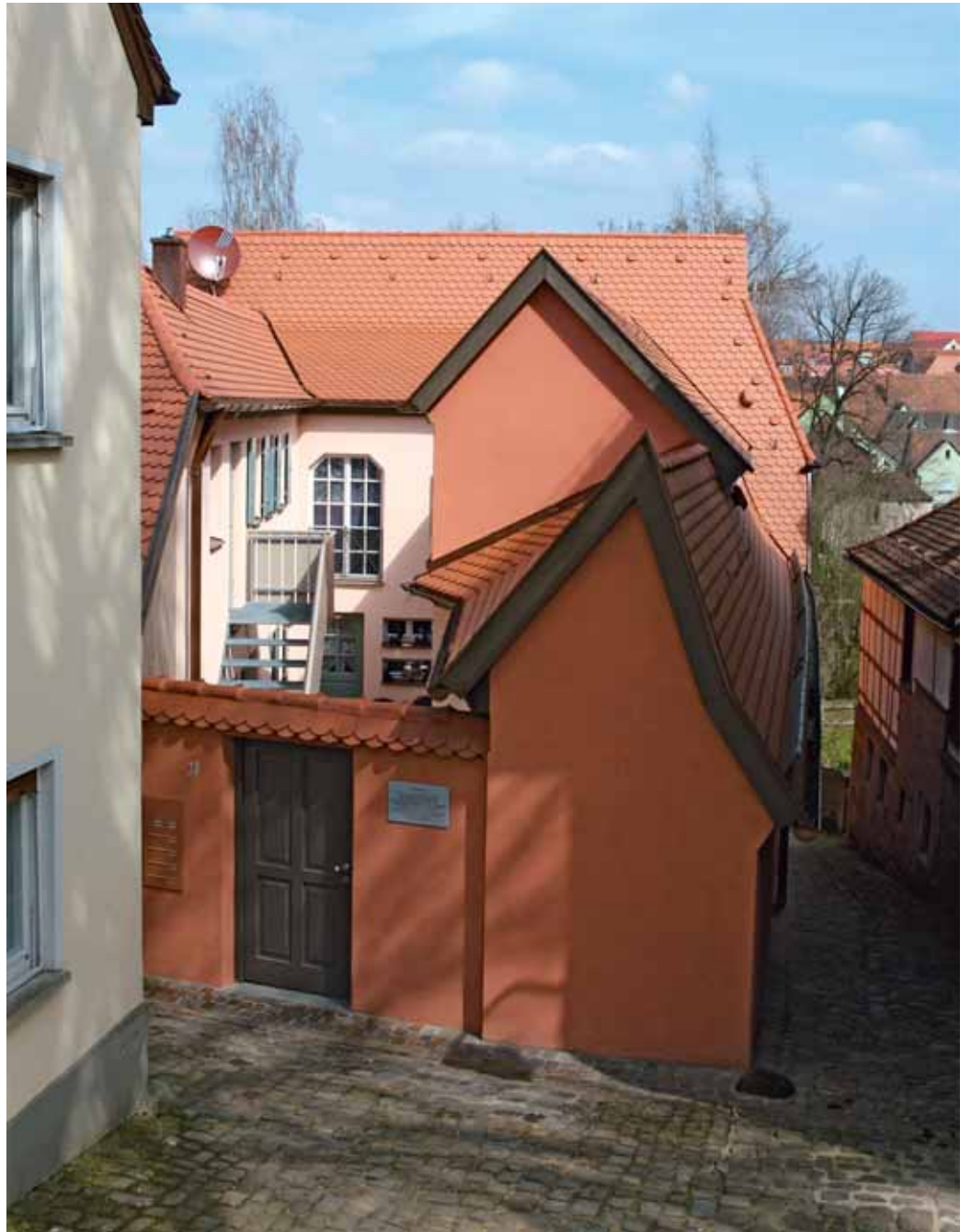
▲ Zeitliche Abfolge der verschiedenen Schritte der Instandsetzung: links oben: erste Untersuchungen im Jahr 1995. Links unten der von einem Vorbesitzer „teilrenovierte“ Zustand 2004 (nach Erwerb durch die Gewobau Schwabach), vor Beginn der Sanierung. Oben: die Südansicht nach der Instandsetzung 2007.
