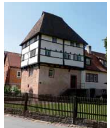
▲ Abb. 5 Amorbach (Ufr.), sog. „Templerhaus“ Ehemaliger Ministerialiensitz. Fachwerk von 1291 auf älterem Unterbau. (Abb. 5 und 6 wurden freundlicherweise von Robert Giersch zur Verfügung gestellt.)
