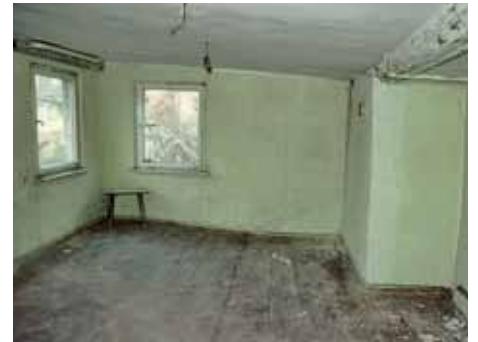
▲ Bohlenstube vor der Demontage der Wandverkleidung.
