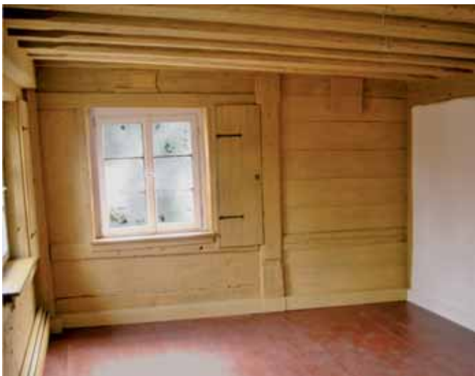
▲ Bei einem Wandteil der Bohlenstube war in früherer Zeit das Holz durch Mauerwerk ersetzt worden, es wurde in seinen ursprünglichen Zustand zurückversetzt (s. a. S. 14, Abb. 11)
