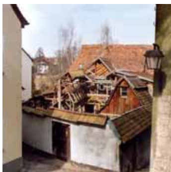
▲ Abb. 14 Blick von Süden auf die Gebäude des Innenhofs: Im oberen Bereich wurde die Ausfachung schon teilweise entfernt.
