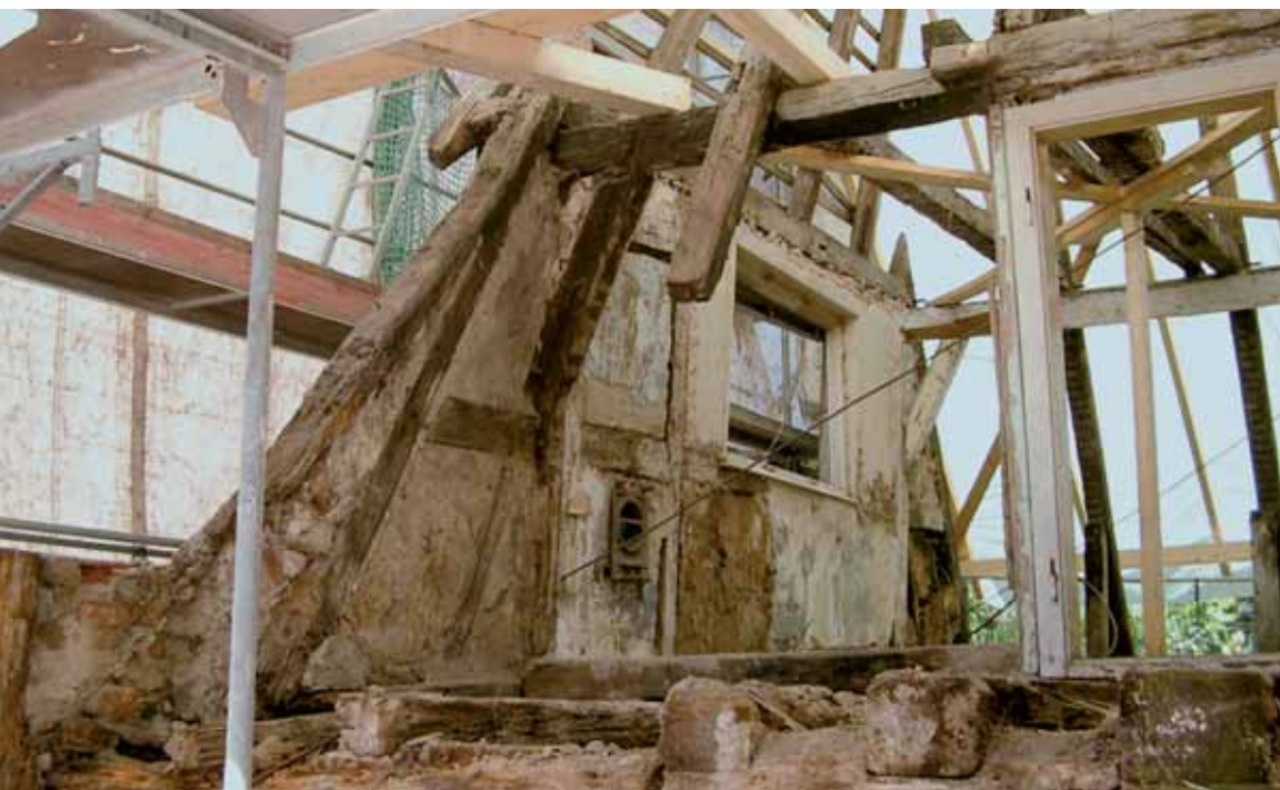
◀ Die Schäden an den Holzbauteilen waren groß und erst nach dem Entkernen richtig sichtbar. Links: Haupthaus, Schäden an westlicher Giebelwand, oben: marode Deckenkonstruktion.
