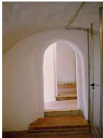
▲ Blick in den Gewölbekeller.
