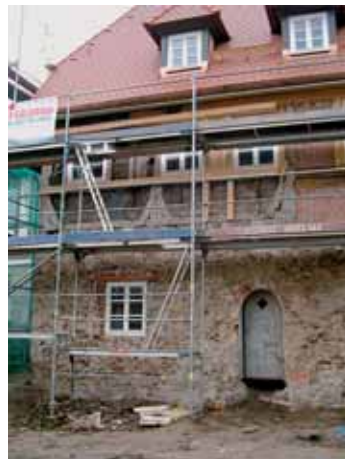
▲ Nach der Abnahme des Putzes werden Bruchsteinmauerwerk und Fachwerk an der Nordfassade sichtbar.
