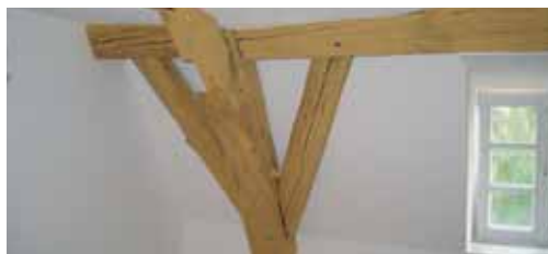
▲ Liegende Stuhlkonstruktion im Dachgeschoss des Haupthauses, Stuhldetail vor und nach der Instandsetzung.
