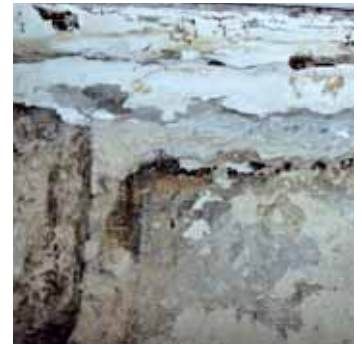
▲ Abb. 12 Gefachputz an der östlichen Innenfachwerkwand im Bohlenkontorraum. Es sind zwar gelbe bzw. rote Holzanstrichverbreiterungen ablesbar, sie gehören jedoch nicht zu den frühesten Farbgestaltungen, sondern die Schwärzungen, die am rechten, mittleren Bildrand erkennbar sind (Raum 0.08/Wand b).
