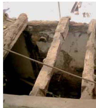
◀ Die Schäden an den Holzbauteilen waren groß und erst nach dem Entkernen richtig sichtbar. Links: Haupthaus, Schäden an westlicher Giebelwand, oben: marode Deckenkonstruktion.
