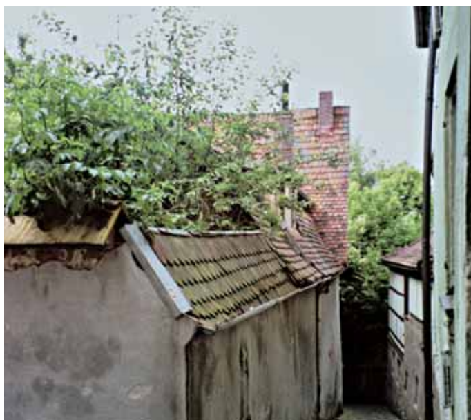
Der Zustand im Juni 2004: Der Bau ist abgestützt, Wände mussten zum Teil mit Armierungseisen gesichert werden, der Hof ist zugewuchert, mit allerlei Material vollgestellt, Dächer sind stark beschädigt, Teile der Zinkburg abgetragen.
