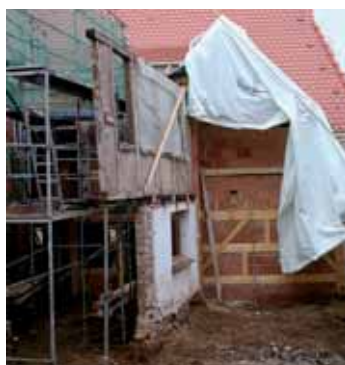
▲ Die hofseitige Wand des Ostflügels musste zeitweise am Gerüst verankert werden. Es wurde dafür zusätzlich verstärkt.
