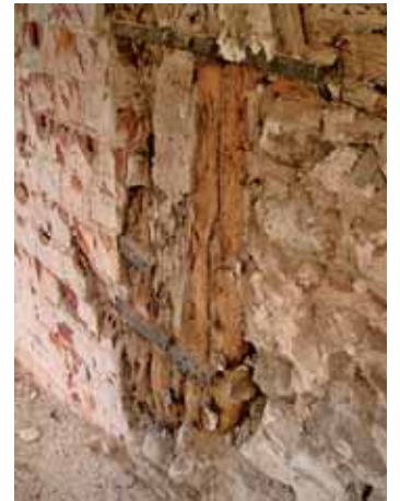
So sah die „Zinkburg“ im Frühjahr 2006 aus: nach dem „Entmüllen“ des Innenbereiches und des Hofes, entrümpelt und entkernt. Der Putz an den Fassaden ist entfernt, Fachwerkkonstruktionen freigelegt, Schäden u. a. an tragenden Elementen werden sichtbar.
