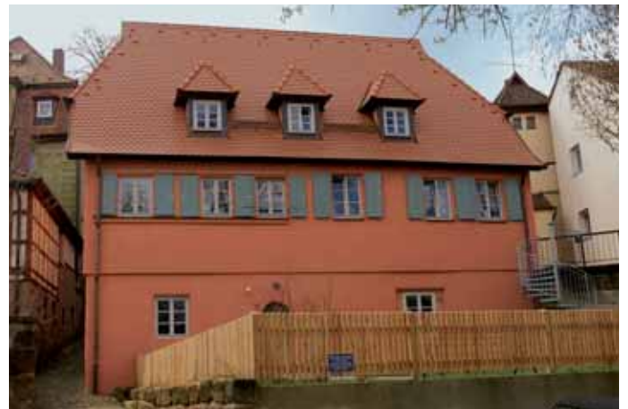
▲ Ansicht der Nordfassade im Jahr 1995, vor Beginn der Sanierung 2004/2005, Zustand heute.
