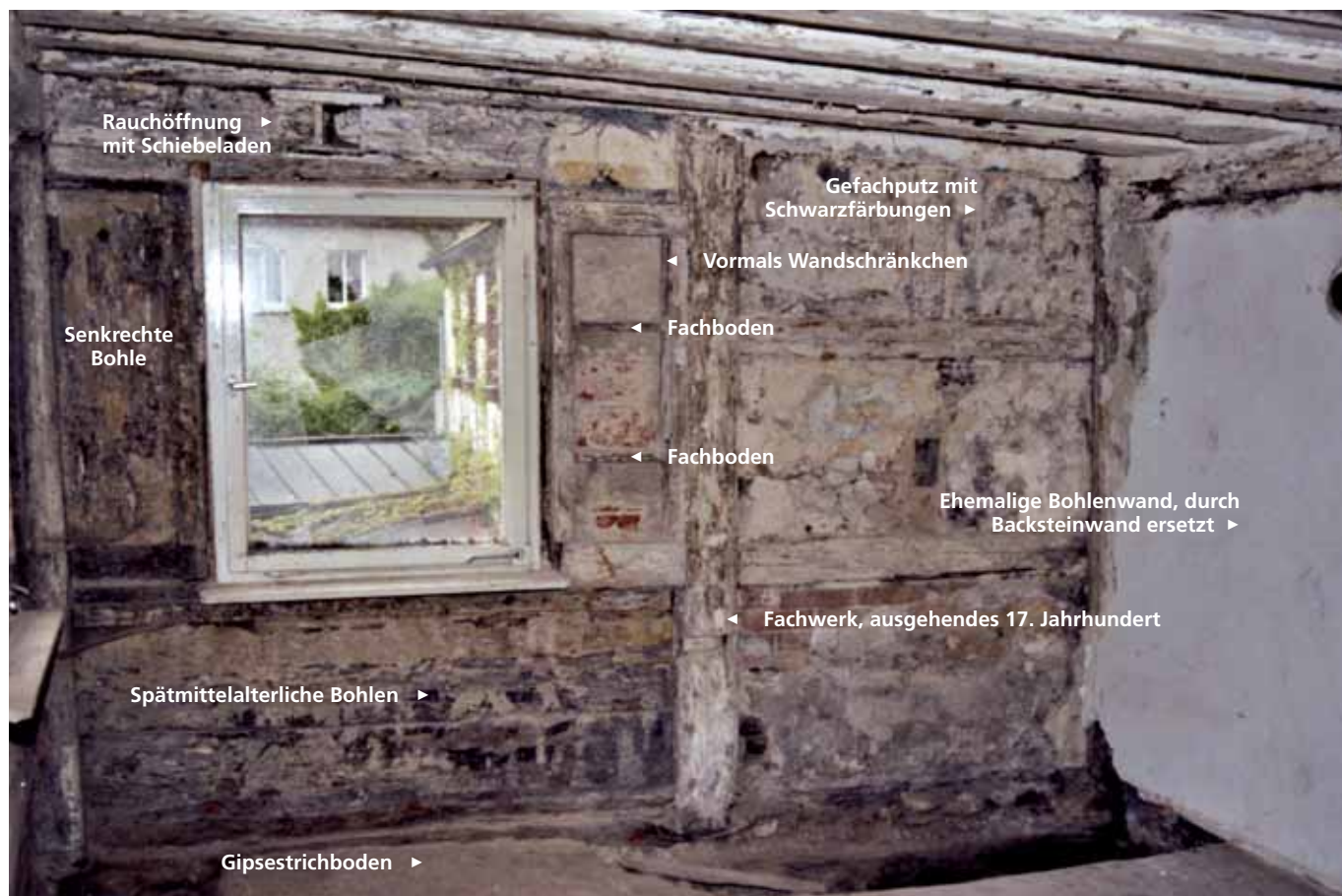
▲ Abb. 11 Die Ostwand im Bohlenkontorraum nach der Freilegung. Das Fachwerk der rechten Wandhälfte ersetzte mittelalterliche Bohlen. Die drei zuletzt „ausgemauerten“ Wandschränkchen in der Ost- und Nordwand wurden erst zum Zeitpunkt der Gebäudeumnutzung im ausgehenden 17. Jahrhundert eingebaut.
