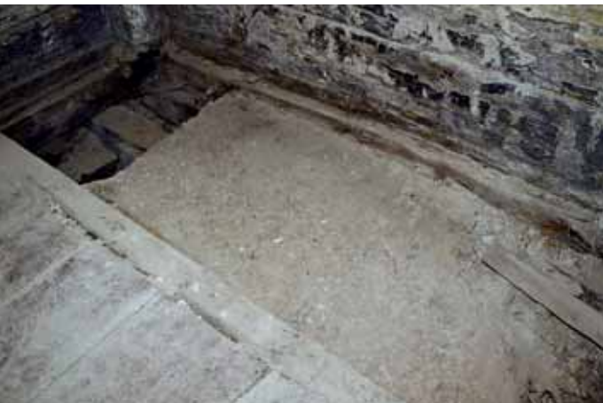
▲ Abb. 6 Aufgedeckter Gipsestrichboden nach der Aufnahme der jüngeren Bodendielen.
