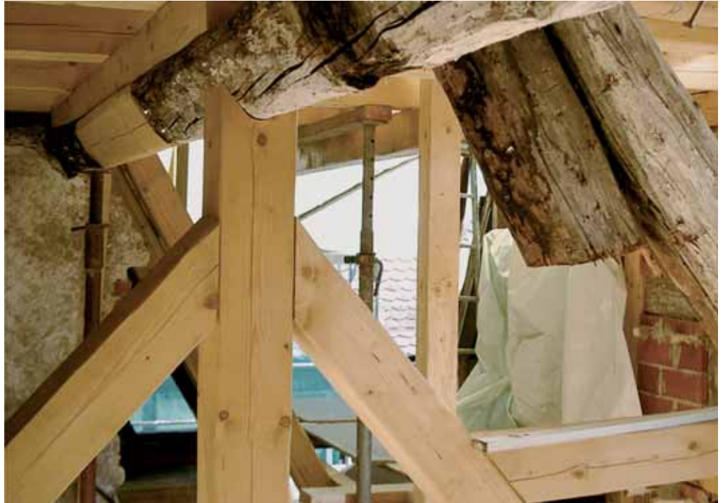
▲ Alte Konstruktionen wurden sorgsam ergänzt, um so viel Substanz wie möglich zu erhalten, hier und links oben im Bereich des Dachstuhls.
