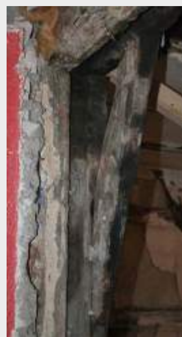
Abb. 6 Die südöstliche Eckausbildung des ehemals verbohnten Kontorraumes im Obergeschoss zur Bauzeit.
