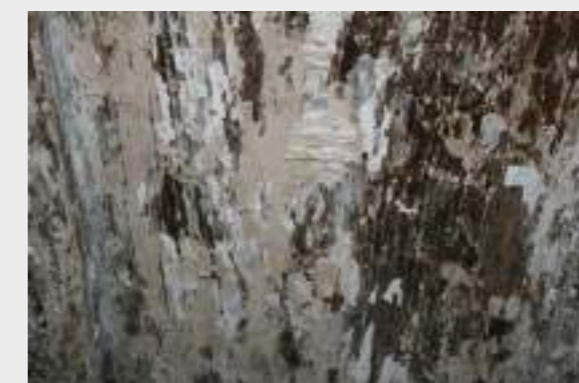
Abb. 12 Mehr als deutlich sind wie hier auf der Bretterbalkendecke im Obergeschoss lediglich helle Kalkschichten erhalten. Nach unten lassen sich die in ein leichtes Grau gehenden Verfärbungen sicherlich in erster Linie mit einem Durchbluten der mittelalterlichen, weil rußig-fettigen Holzbehandlung der Balken und Bretter erklären.
