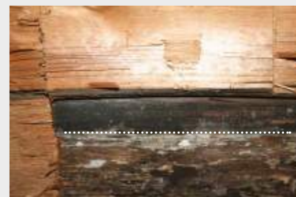
Abb. 9 Nicht nur an dieser Stelle der Bretterbalkendecke wird der Kontrast zwischen dem rohem Holz und der geschwärzten Brettoberfläche selbst für das Auge nachvollziehbar. Dabei handelt es sich um eine Ausbruchstelle der Nut, d. h., dass dieser Brettbereich vorher durch die Nut abgedeckt gewesen war. Das Brett muss bereits vor dem Einschub dunkel lasiert gewesen sein.
