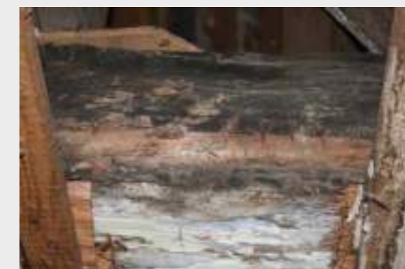
Abb. 10 Nicht nur an diesem Deckenbalken wird belegbar, dass die heutigen Lehmwickeldecken nicht mehr mittelalterlichen, sondern neuzeitlichen Ursprungs sind. Da damals der sog. Kleiber, der für deren Einbau verantwortlich zeigte, die Dreiecksnuten für die Staken nachträglich einzog.
