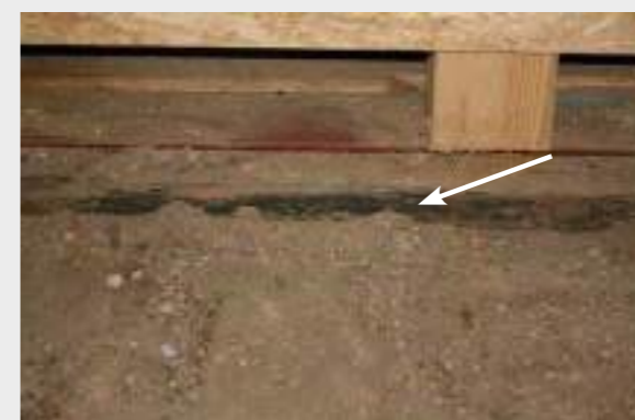
Abb. 11 Der Schwellbalken der ehemaligen, westlichen Bohlenwand im oberen Kontorraum. Die bauzeitliche Bisterlasur wurde auf alle Flächen aufgetragen, wie hier seitlich des Balkens bis zur Oberkante Balken.
