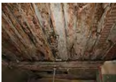
▲ Freigelegte Spunddecke im Erdgeschoss
