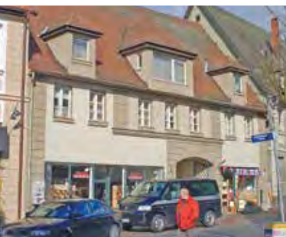
▲ Fassade des Hauses Kappadocia 9 vor der Sanierung – diese Aufnahme entstand im März 2008. Die vier Figuren zwischen den Lisenen im Obergeschoss sind hier schon überstrichen, die Neon-Reklameschriften entfernt.
