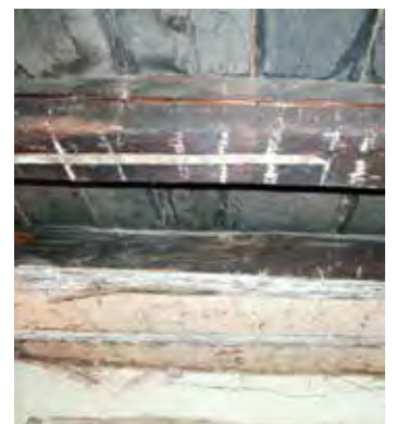
▲ Raum 1.02. Im direkten Vergleich: die bauzeitliche Deckenkonstruktion mit offener Balkenlage und aufliegendem Dielenboden, nach hinten die Balkenlage mit nachträglich eingebauter, barocker Lehmwickeldecke.
