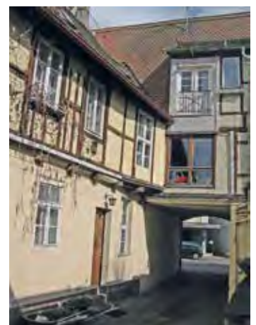
▲ Der erste Anschein trügt: Die Sichtfachwerkfassaden mit schlichten Ständer-Riegel-Konstruktionen ließen zunächst nicht erahnen, dass die Errichtung des Anwesens wesentlich weiter zurückreicht als zuvor angenommen.
