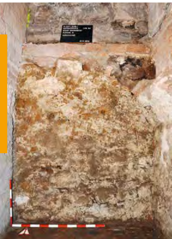
▲ Teilweise wieder freigelegt: Nördliche Kellerwand im Nordtrakt mit einem Gewölbeansatz, der auf eine Breite des Kellers von etwa 3,1 Metern schließen lässt. Fundort: siehe Grundriss S.8/9, 7
