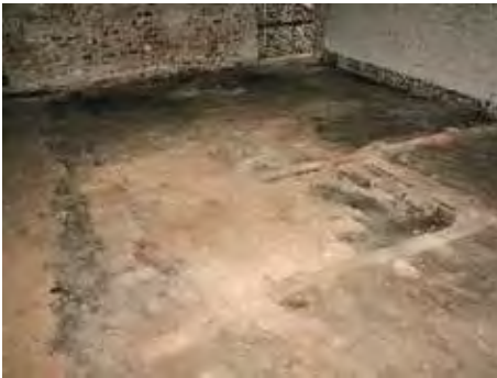
▲ Zu Beginn der Sanierung erfolgte die Herausnahme der modernen Bodenaufbauten im Südflügel, es wurden
