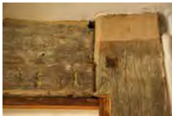
▲ Bohlenwände im ersten Obergeschoss des Vorderhauses: Sie bleiben an Ort und Stelle und stehen als sichtbare Zeugen für das Alter des Anwesens. Die Details zeigen den außerordentlich guten Erhaltungszustand der Holzbohlen.
