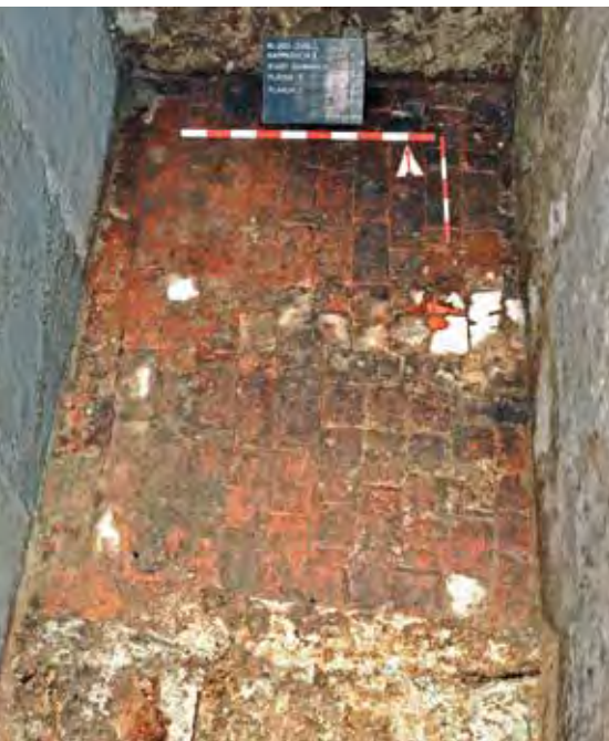
▲ Pflasterung des Kellerbodens, gleiche Ziegelsteine wurden auch für den Belag der Hoffläche verwendet. Dieser Keller wurde wohl Mitte des 16. oder im Lauf des 17. Jahrhunderts erweitert. Fundort: siehe Grundriss S.8/9, 7
