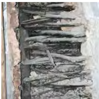
▲ Innenansicht eines bauzeitlichen Flechtwerks in einem Gefach des nördlichen Fachwerks.
