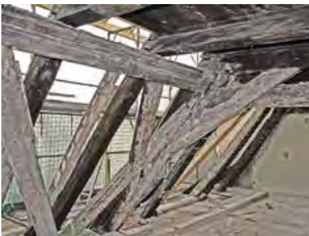
▲ Dachgeschoss, Vordergebäude. Eine der liegenden Stuhlsäulen mit Strebe, die zum Kehlbalken bzw. unterem Spannriegel und zur Säule die Blattverbindungen zeigt.
