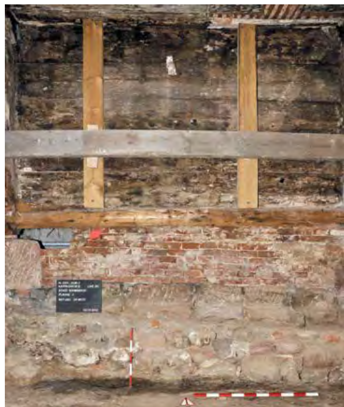
▲ Oben eine dunkle Bohlenwand aus dem ersten Drittel des 16. Jahrhunderts mit darunter liegender Sandstein-Fundamentmauer, wohl vor 1526/27 errichtet. Fundort: siehe Grundriss S.8/9, 6
