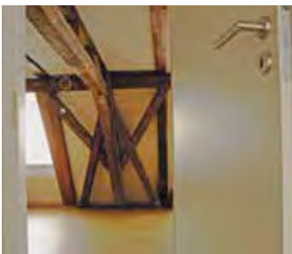
▲ Durchblick in die Küche der Vorderhauswohnung 4
