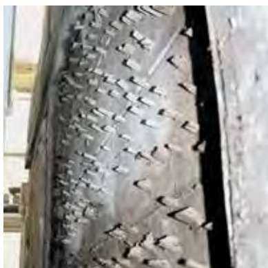
▲ Nordfassade. Außenansicht der Bohlenaußenwand im Obergeschoss mit eingeschlagenen Eichenkeilen, die dem Lehmämmverstrich Halt geben sollten.
